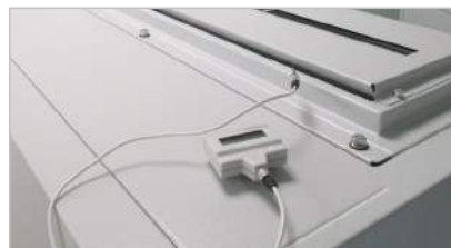
Messung der Temperatur der Luftaustrittsströmung
